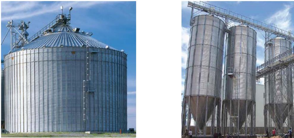
**Figura 1.9.** Silo convencional (fondo plano), izquierda, y silos tolva (“hopper silos”), derecha (GSI Grain Systems, 2009)
