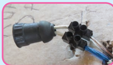
Sumber: Dokumen Kemdikbud Gambar 2.41 Pemasangan stand lampu lombok.
