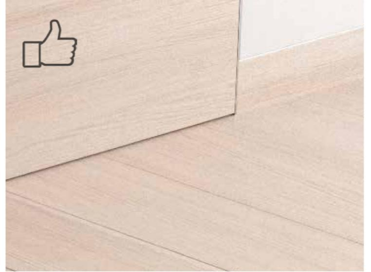
Il battiscopa standard, sulla sinistra, ha una rifinitura esteticamente meno pulita in abbinamento con una porta filomuro. rispetto a quella del battiscopa filomuro, complanare con l'anta della porta.
