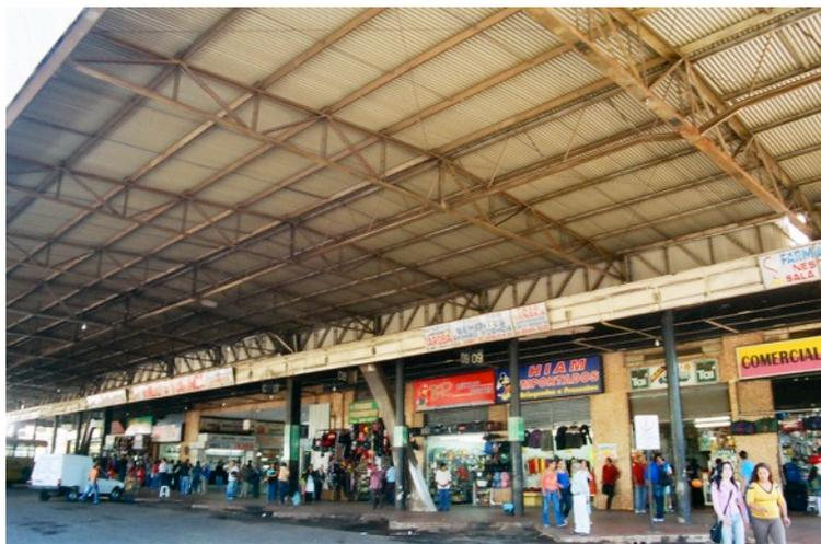
**Figura 33** - Parte da estrutura metálica cujo desabamento deu origem às ações de desapropriação e demolição pelo poder público, em 13 de agosto de 2005
